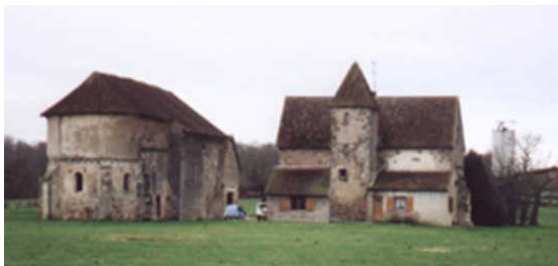
Maison du Temple Le Feuilloux - Image O.S.J
